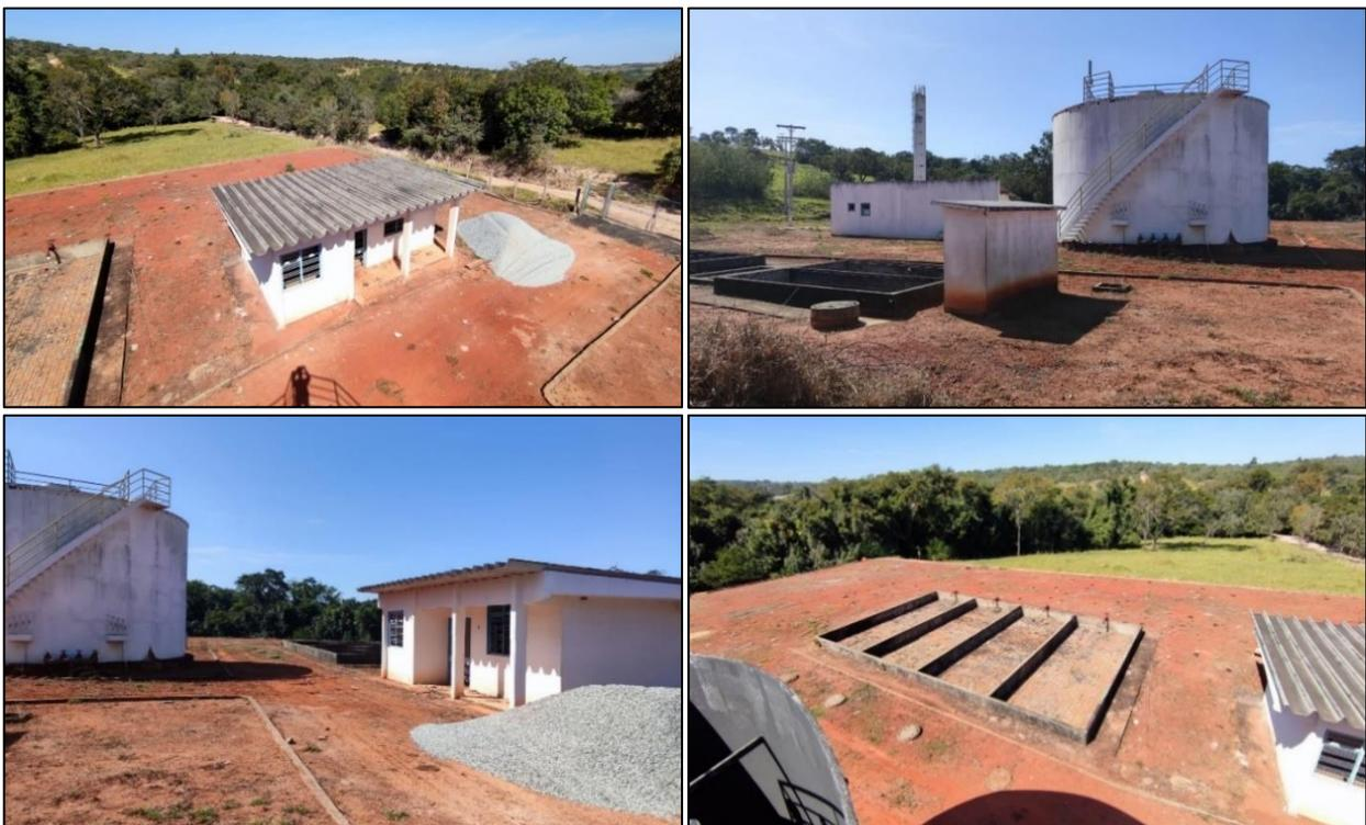
Figura 54 – Registro fotográfico das obras inacabadas do sistema de esgotamento sanitário de Goiandira – ETE.
